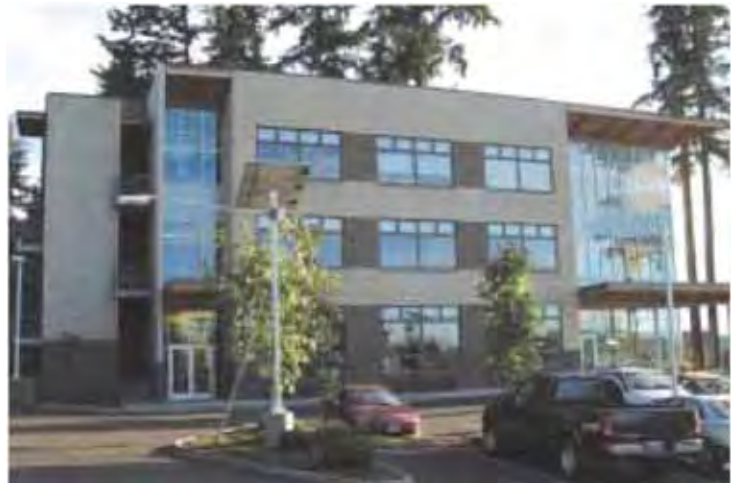
El Edificio Viridian de RTJ Partnership en Portland, OR, obtuvo una certificación LEED Versión 2.0 el 11 de Diciembre de 2001.
